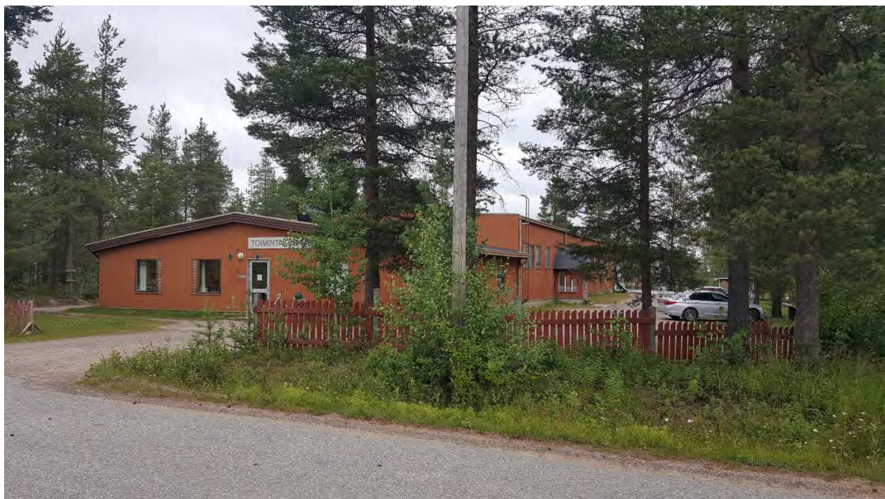
Julkisivu ja piha-alue Teollisuustieltä katsottuna
