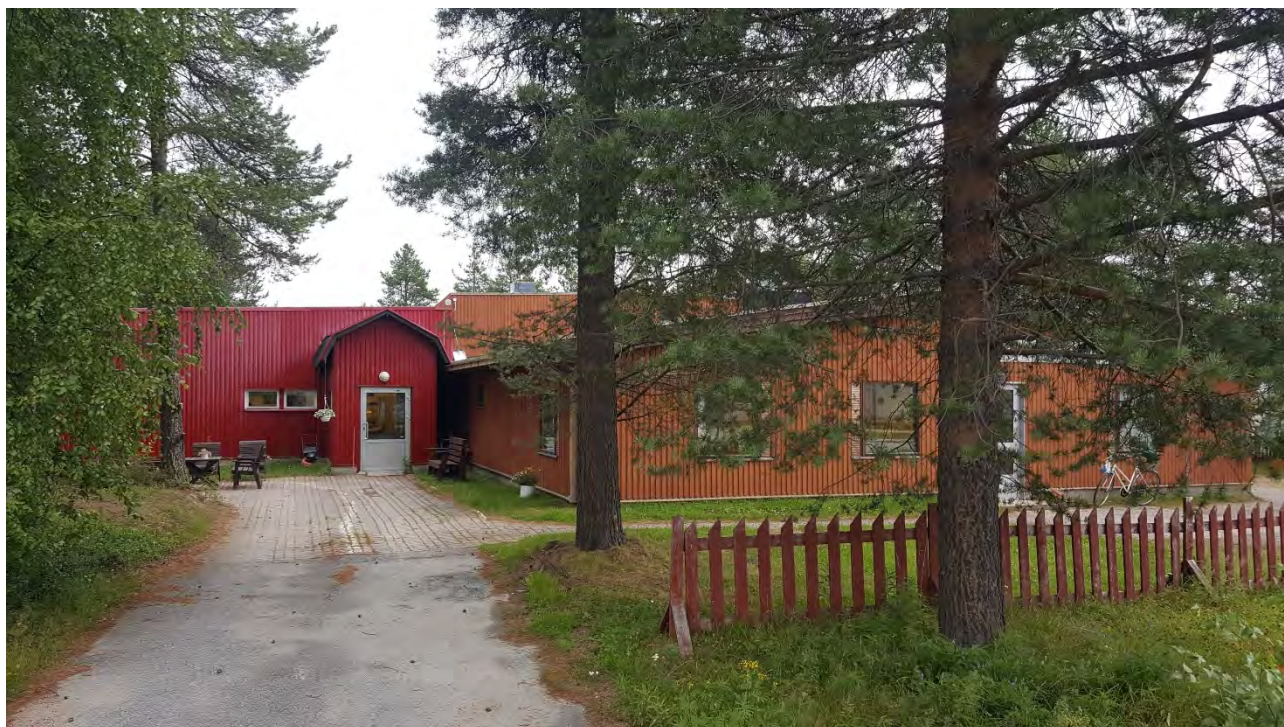
Julkisivu Teollisuustieltä katsottuna
